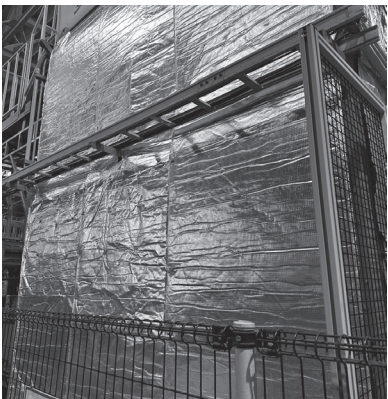
写真－3 遮断熱マット施工例
