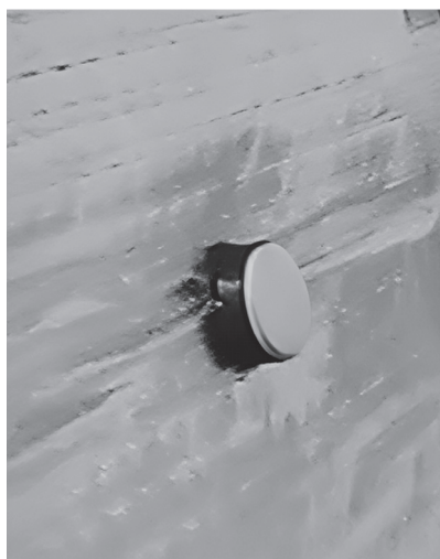
写真-5 遮断熱マットの磁石施工例
