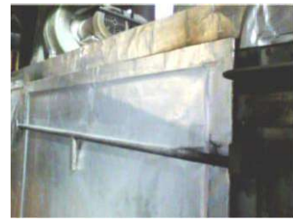
遮熱シート 施工後
