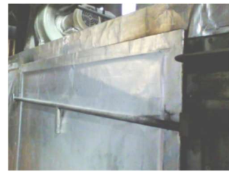
遮熱シート 施工後
