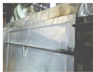
遮熱シート 施工後
