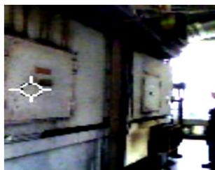
遮熱シート 施工前
