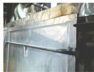
遮熱シート 施工後
