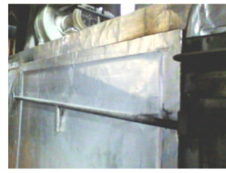
遮熱シート 施工後
